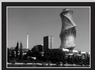
SEDE CENTRAL DE LOS LABORATORIOS ROCHE EN BASILEA, SUIZA. ROCHE
