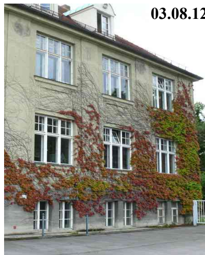
Nordfassade, freie Sicht zur Sendeanlage Eichamt Messung: 4.980 \mu\text{W}/\text{m}^2
