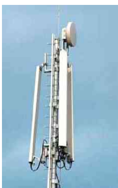
typische Mobilfunkbasisstation mit drei Sektorantennen und Richtfunk
